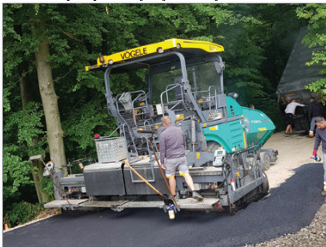
Asfaltiranje ceste JP 703-601- Andrenci-Vršič.jpg
