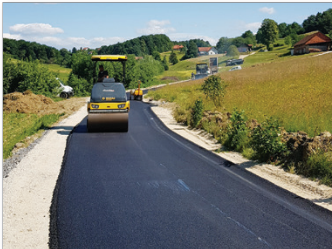
Asfaltiranje ceste JP 703-541 na odseku Andrenci - Smej- Peščeni Vrh
