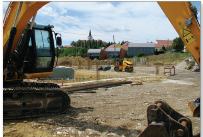
Začela se so gradbena dela na izgradnji Poslovnega objekta v katerem bosta tudi živilska trgovina in lekarna in nekateri drugi lokali.
